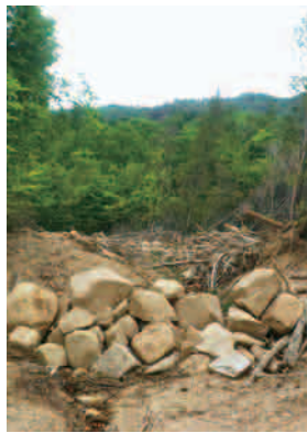
▲高屋町小谷の被災現場
