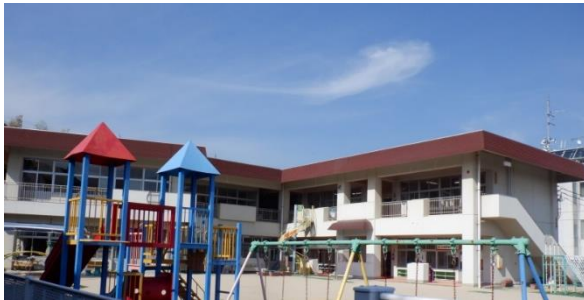
改修する三津保育所
