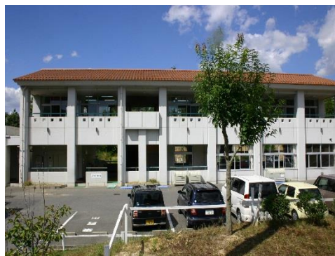
上黒瀬小学校特別教室棟
