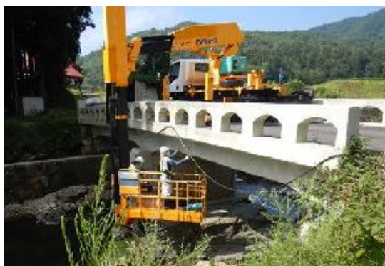
橋梁点検の様子
