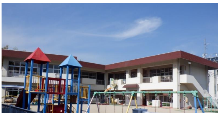
改修する三津保育所
