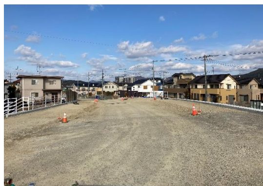
整備中の西条中央巡回線
