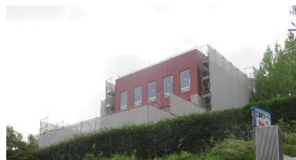
～工事中の本校舎～
