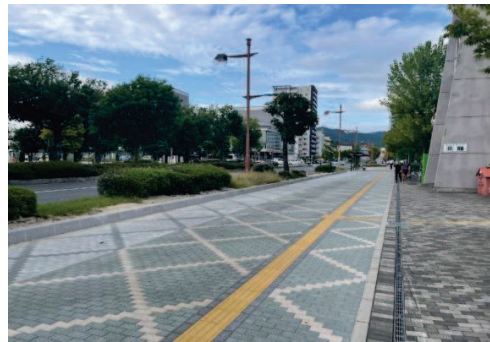
▲ブルバール空間再構築 (自転車道・歩道分離) 資料：東広島市
