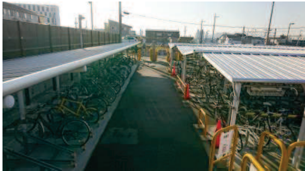
▲JR寺家駅駐輪場整備 (H29.3) 資料：東広島市
