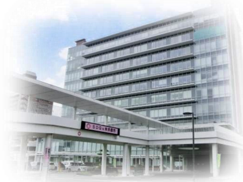
東広島市役所本館
