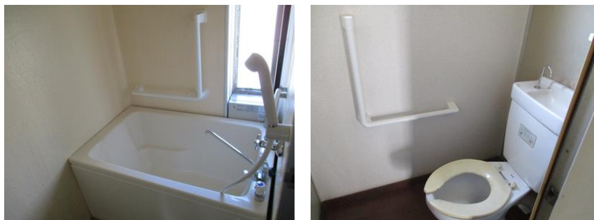
【図 3-8】住戸内手すりの整備
