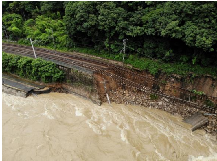
河内町 下河内地区（J R山陽本線）
