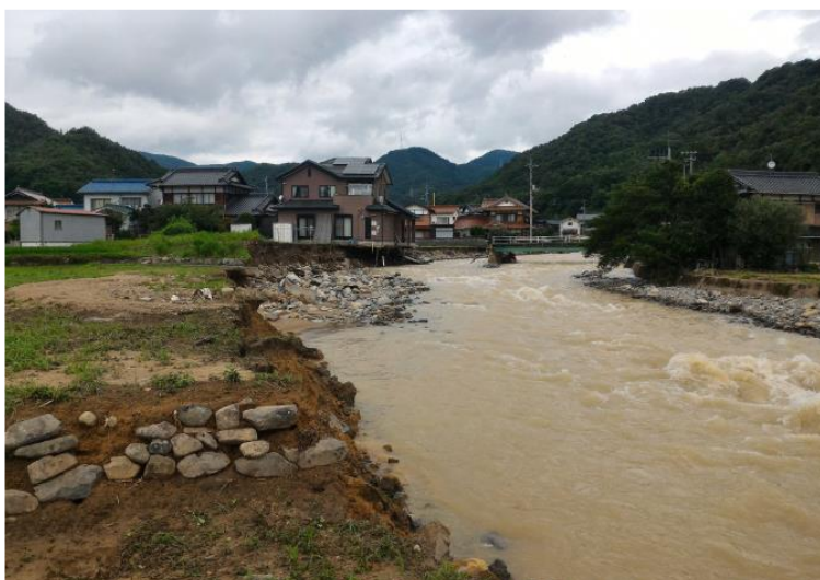
安芸津町 三津地区（三津大川氾濫による護岸の浸食）
