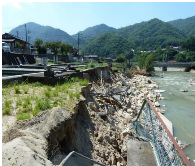
河内町 中河内地区（沼田川）
