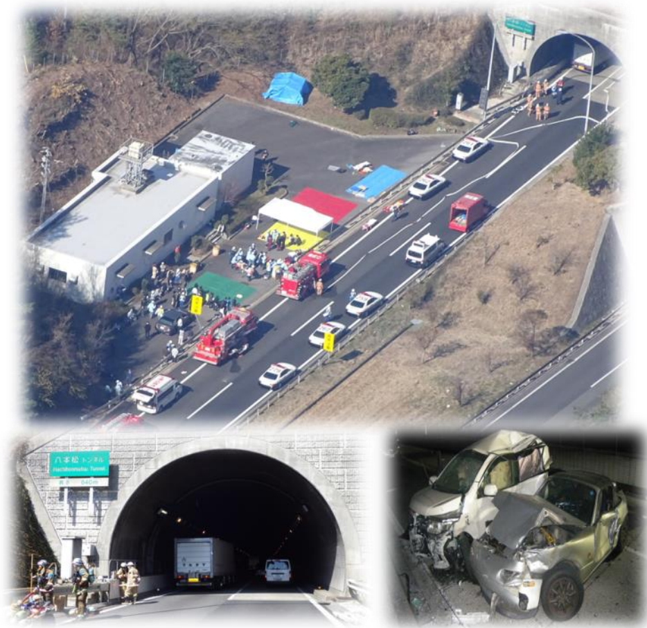
平成28年3月 山陽自動車道八本松トンネル車両火災
