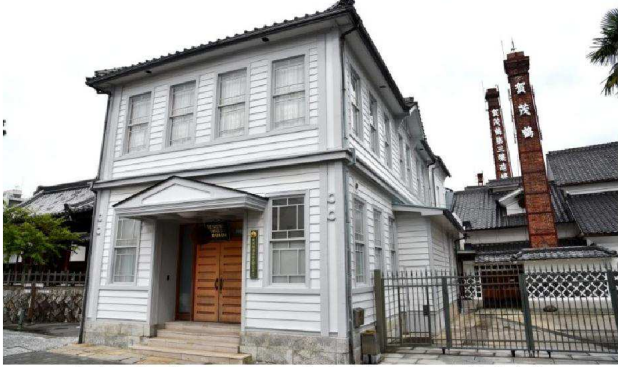
本社事務所・二号蔵煙突・三号蔵煙突
