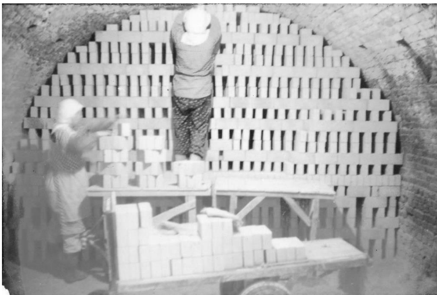
写真③ かま 窯詰作業
