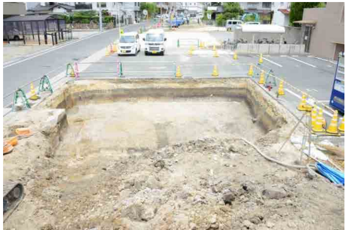
A調査区完掘状況（下層面：南から）
