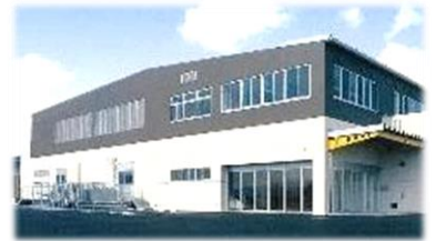
東広島学校給食センター
