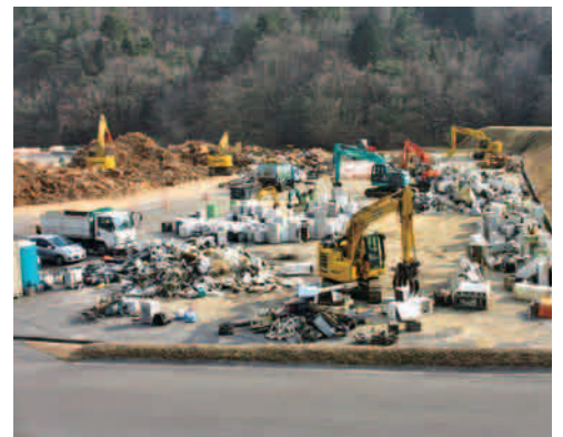
災害廃棄物処理現場(黒瀬町国近)
