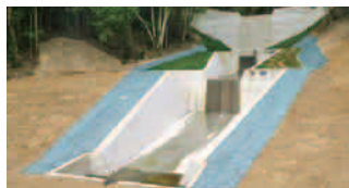
堰堤工事（高屋町）
