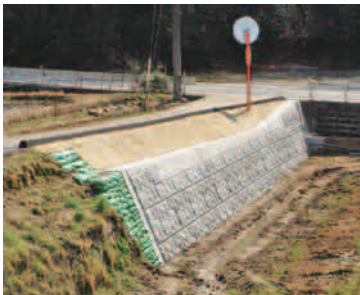
福富町 市道古市原1号線 (工事完了)
