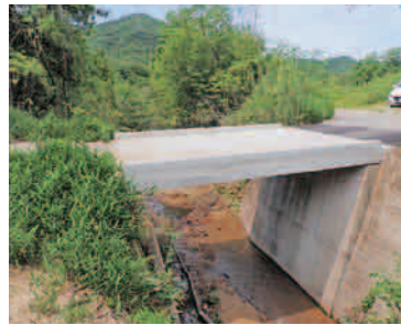
西条町 市道郷曾25号線(橋梁) (工事完了)
