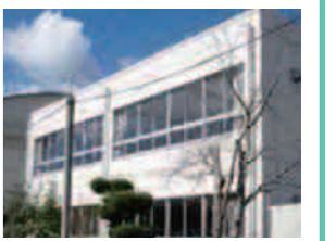
西志和地域センターに改修予定の旧西志和小学校特別教室棟▶
