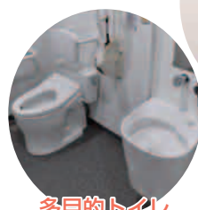
多目的トイレ
