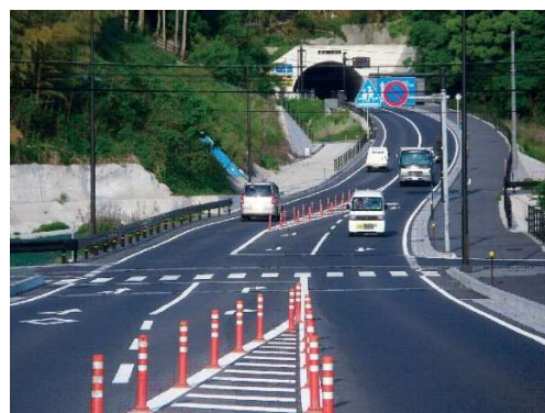
図 国道 185 号安芸津バイパス
