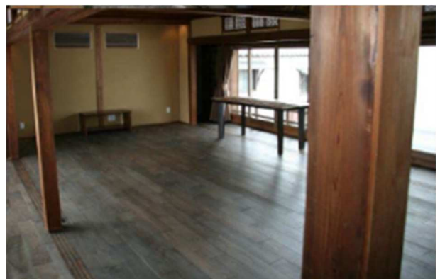
空き家のリフォーム
