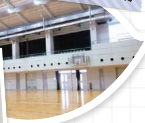
屋内運動場空調設備
