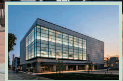
2020.11 市立美術館移転開館
