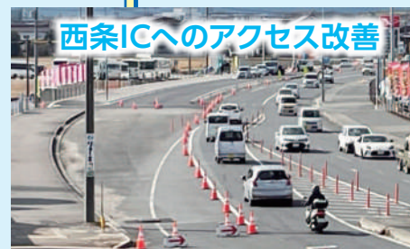
御園宇交差点から田口へ進む拡幅工事 (令和7年1月24日撮影)
