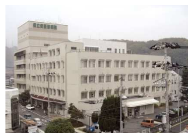
県立安芸津病院
