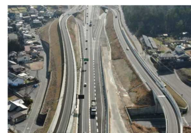
国道2号安芸バイパス
