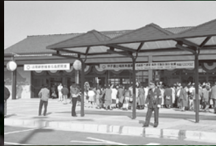
1988.3 山陽新幹線 東広島駅開業
