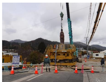
橋梁災害復旧工事の様子
