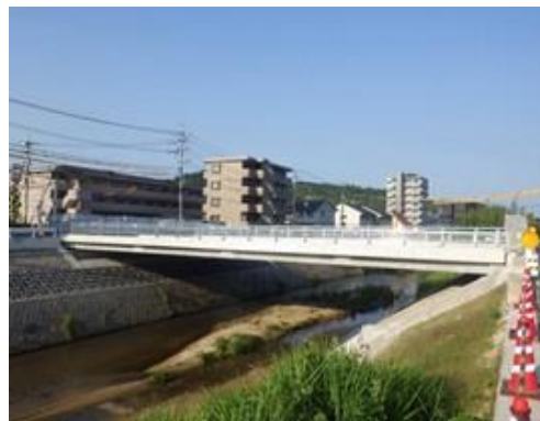
西条中央巡回線 (江熊新橋)
