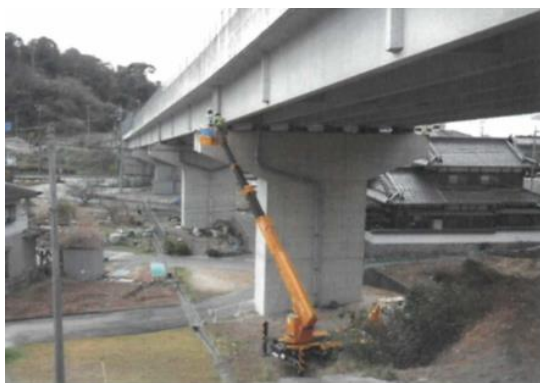
橋梁点検の様子
