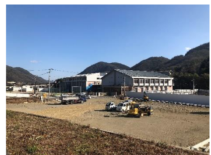
河内小中学校造成工事の様子
