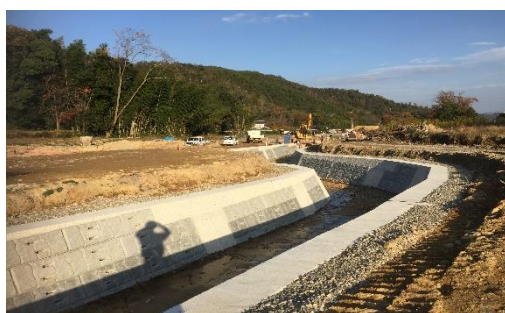
河川災害復旧工事の様子
