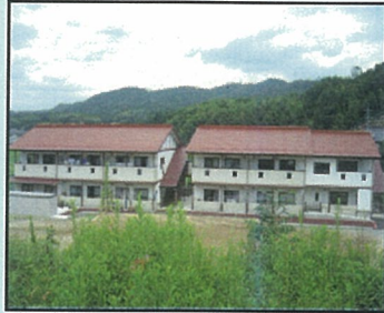
公営住宅整備事業
