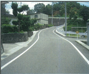
道路改良(市道小谷12号線)
