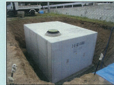
防火貯水槽設置
