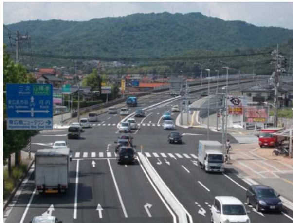
▲国道375号御園宇バイパスの4車線化 (H26：藤田沖(南)～御園宇4車線拡幅)
