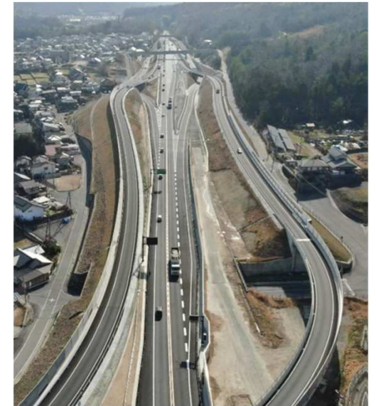
▲国道2号安芸バイパスの整備 (R5.3：全線開通（暫定2車線）)
