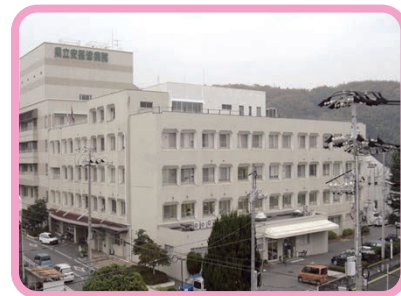
県立安芸津病院
