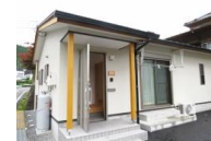
空き家の改修（お試し居住施設）
