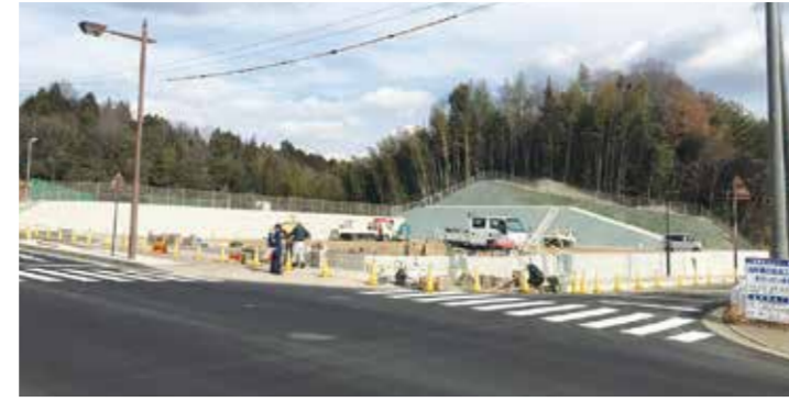
造成中の建設予定地
