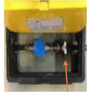
Van khóa nước (Trạng thái khóa nước là khi van màu trắng nằm ở vị trí vuông góc với đường ống nước)
