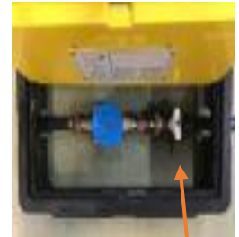
Van khóa nước (Trạng thái khóa nước là khi van màu trắng nằm ở vị trí vuông góc với đường ống nước)
