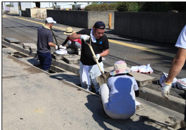
平成30年7月豪雨災害からの復旧
