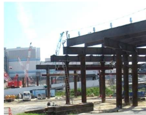
【県道をまたぐ仮設橋工事】
