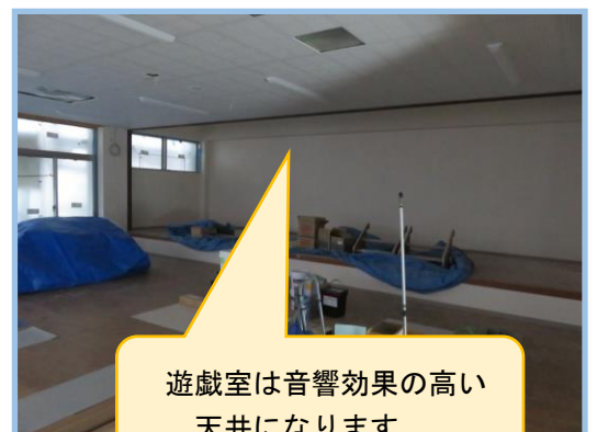
エレベーターがついて、 バリアフリーになります
