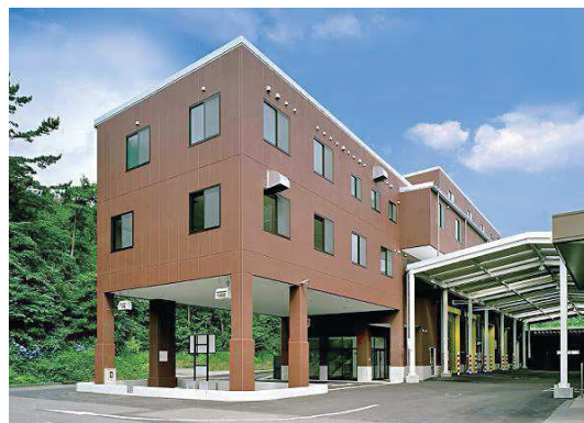
賀茂環境センター
