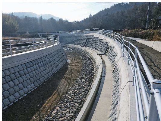
河川護岸整備
