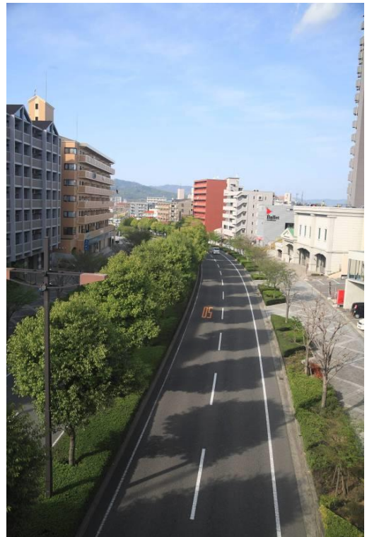
ブルーパール (県道195号西条停車場線)
