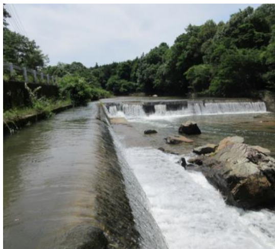
取水堰および導水路
