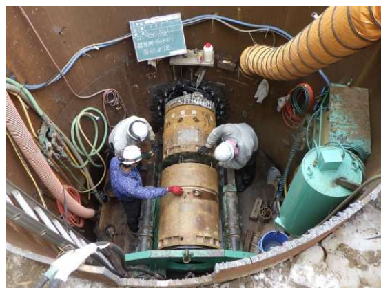
污水管渠の整備工法（左：開削工法、右：推進工法）
