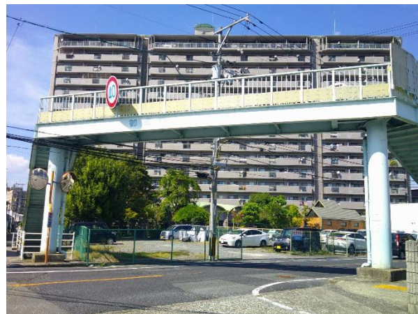
②御条横断歩道橋
