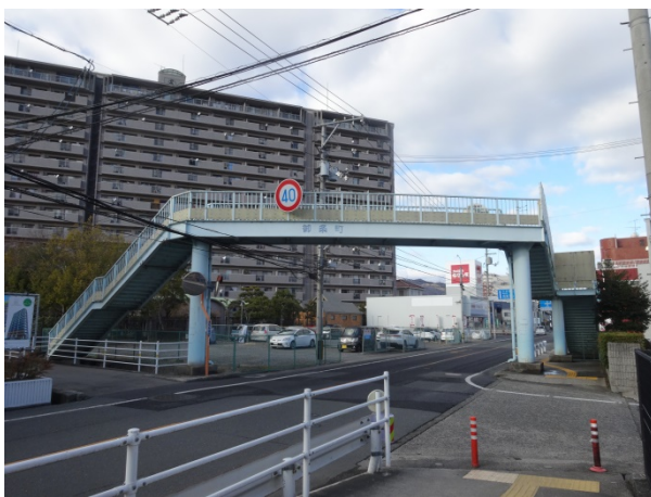
③御条横断歩道橋
