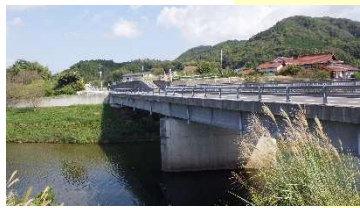
大河内橋 L=60.0m (PC橋)2017 年架設
