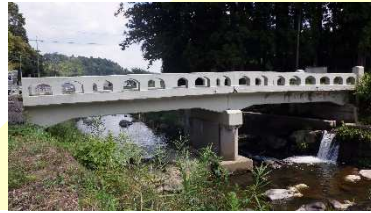
押谷橋 L=16.5m(RC橋) 1960 年架設
