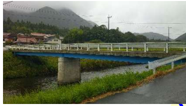
原橋 L=38.0m(鋼橋) 1966 年架設
