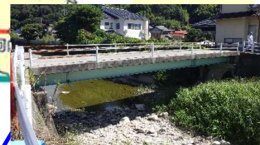
新生橋 L=14.0m(鋼橋) 1970 年架設
