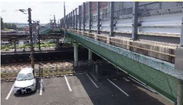
互栄橋 L=117.6m(鋼橋) 1968 年架設
