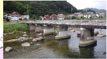
城渡橋 L=51.8m(RC橋) 1959 年架設
