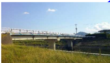
柳国大橋 L=62.0m (PC橋)1970 年架設
