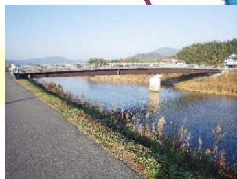
田津原橋 L=70.00m (鋼橋)1994年架設
