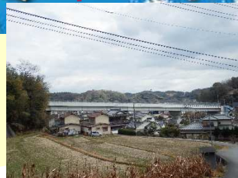
湯盛高架橋 L=160.00m (PC橋)2008年架設
