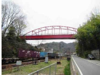
八本松大橋 L=65.00m (鋼橋)1972年架設
