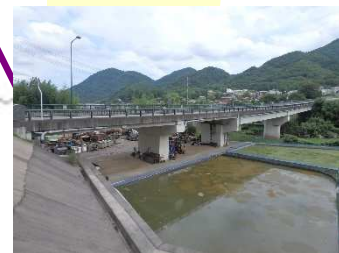
新沼田川大橋 L=194.50m (PC橋)2002年架設
