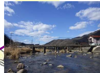
城渡橋 L=51.20m (RC橋)1959年架設
