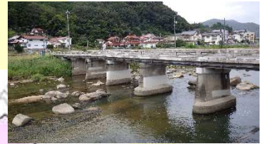
城渡橋 L=51.8m(RC橋) 1959 年架設
