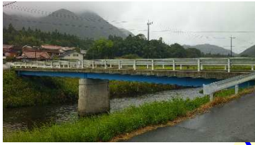
原橋 L=38.0m(鋼橋) 1966 年架設
