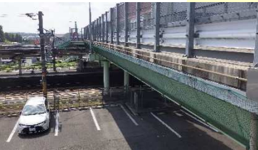
互栄橋 L=117.6m(鋼橋) 1968 年架設
