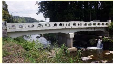
押谷橋 L=16.5m(RC橋) 1960 年架設
