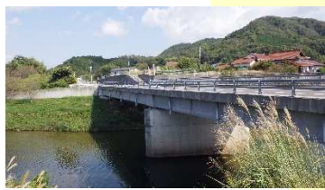
大河内橋 L=60.0m (PC橋)2017 年架設
