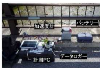
センサーを活用した たわみ計測
