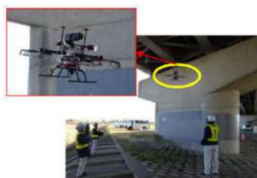
ドローンにより写真を撮影し 画像から損傷を確認
