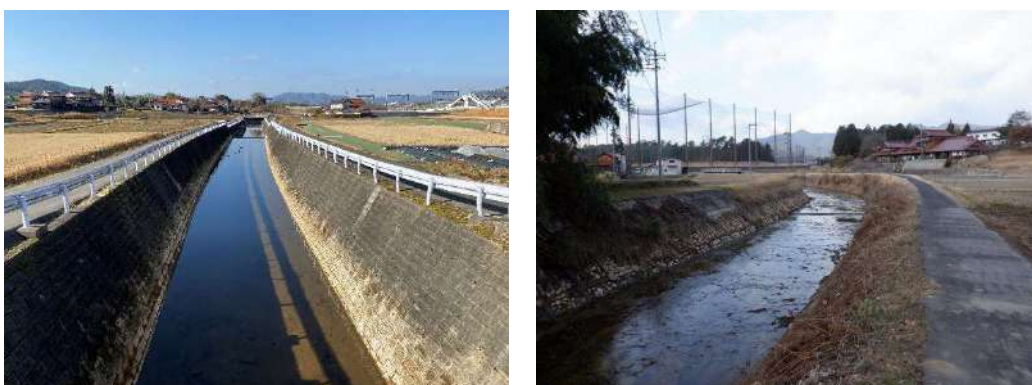
事業中の河川維持修繕事業（左：三永川、右：戸石川）
