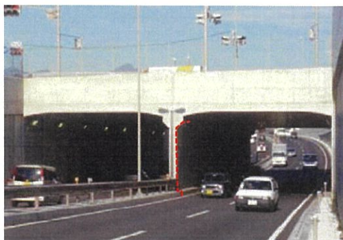
一般国道17号 高松立体(群馬県高崎市)
