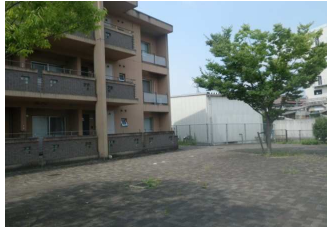
市営鍛冶屋団地及び浄水施設(外観)
