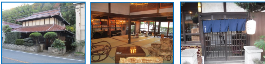
< 空家対策事業費補助金を活用した改修事例 >
