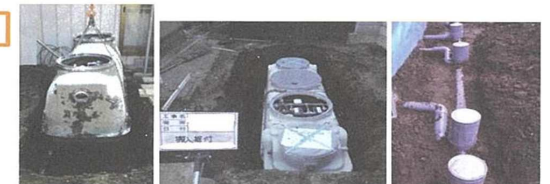
単独浄化槽撤去 合併浄化槽設置 配管工事
