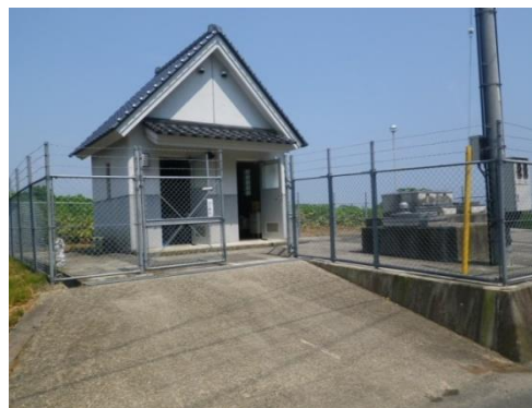
河内 飲料水供給施設
