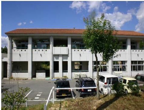
上黒瀬小学校特別教室棟
